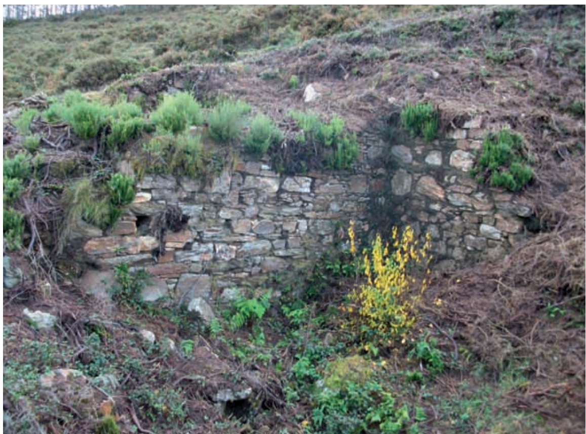
14. Construción a base de muros de mampostería de pedra
