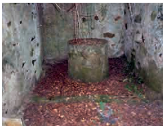
O interior do muíño só garda a pedra macho
