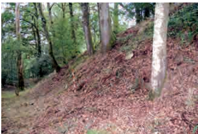
Lám. 31. Detalle da muralla de considerable altitude.
