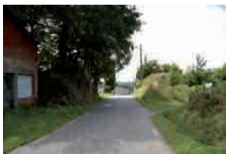
Lám. 18. Alteracións sufridas na muralla do Castro da Igrexa provocadas por accións humanas. Casa á esquerda, pista central que corta as defensas e camiño con construción á dereita.
